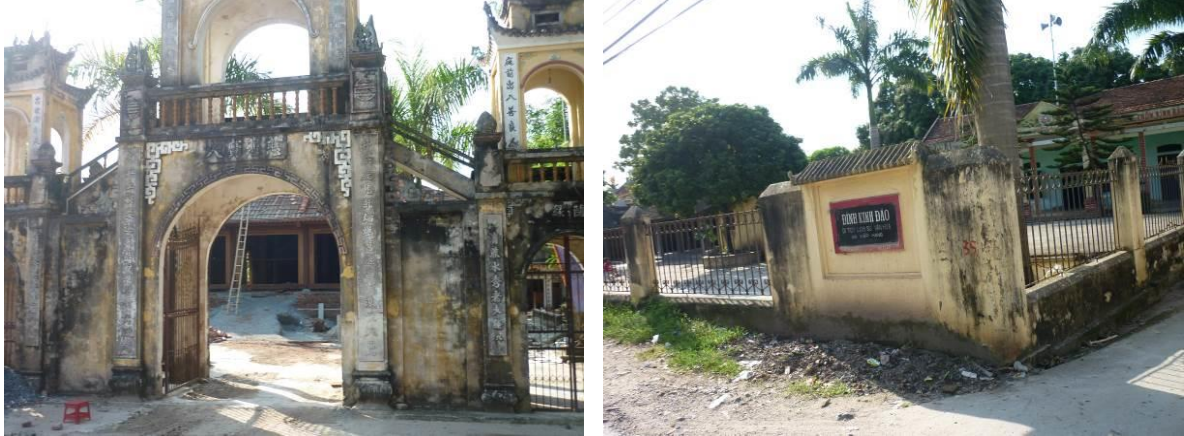
Hình 9: Công trình tôn giáo tín ngưỡng trong các thôn
